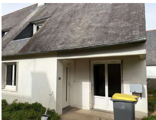
Nouveau logement -Tréguier
